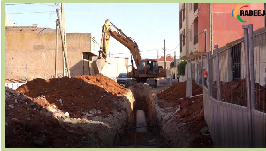
La régie Autonome Intercommunale de Distribution d'Eau, d'Électricité et gestion d'Assainissement liquide des Provinces d'El Jadida et de Sidi Bennour (RADEEJ) poursuit les travaux d'équipement du centre Laâtatra en réseau d'assainissement liquide. L'avancée des travaux a atteint 80% et le projet devrait arriver à son terme fin février 2023.
